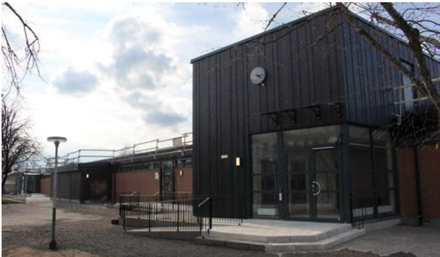
Byggnaden med lokaler för bland annat hem- och konsumentkunskap, träslöjd och textilslöjd har fått nya entréer. De är tillgänglighetsanpassade och har bland annat fått en fasad i mörkt trä.
