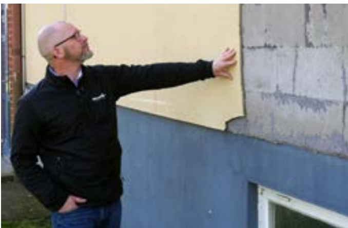
Carl-Magnus Widell vid en av fasaderna som ska renoveras.
