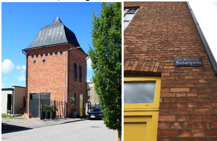
Transformatorstation, är sedan 2007 q i detaljplan.
