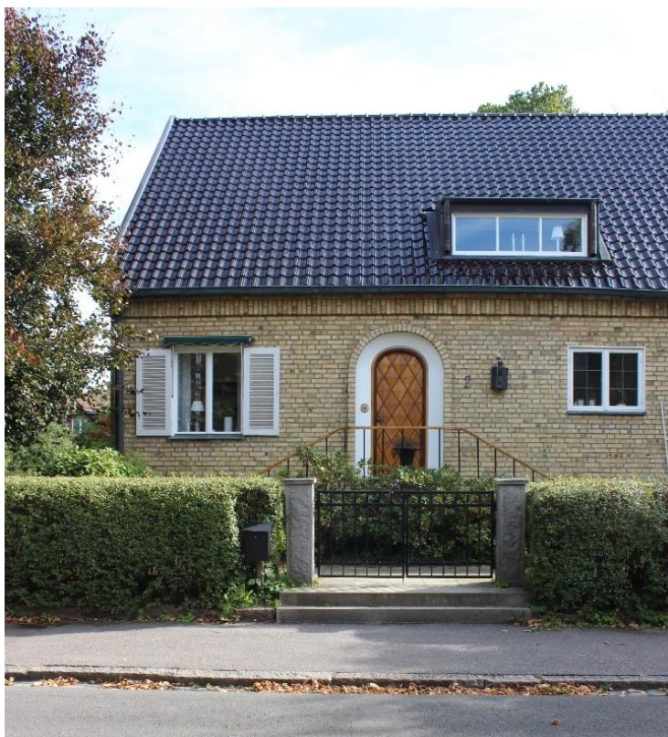
Boken 6 , Polhemsgatan, har genomgått vissa förändringar men har kvar sina omsorgsfullt utformade tegelfasader och sitt tidstypiska dekorativa entréparti.
