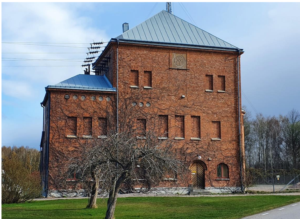
Sekundärstationen i Håkantorp byggdes 1908. Än idag är den en viktig del i elnätet. Den ingår tillsammans med en intilliggande, samtida tjänstebostad och en gård i kulturmiljön Håkantorps gård och sekundärstationen.
