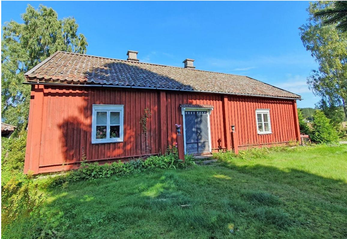
Laske härads tingshus uppfördes 1750–52, och var i bruk som tingsplats till 1887. Intill tingshuset finns även den lilla arresten bevarad, byggd i natursten med gallerförsedda fönsterluggar.
