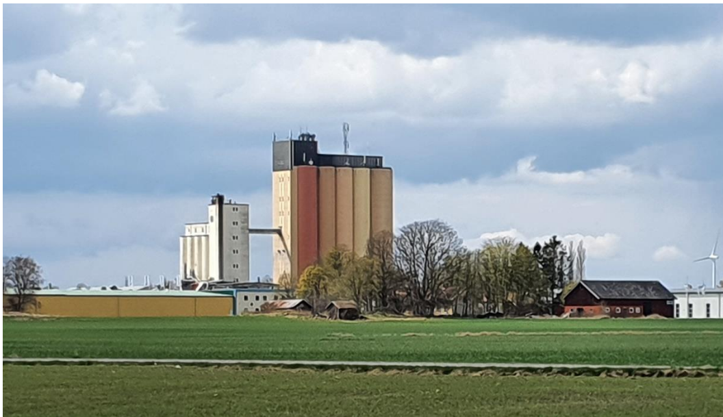
Den höga betongsilon i Kvänum syns milsvida omkring, och utgör ett karaktäristiskt landmärke på den öppna Varaslätten.
