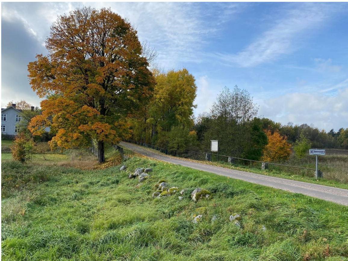
En välbevarad äldre vägsträckning med stenvalvsbro i Eling, strax sydväst om Elings kyrka.
